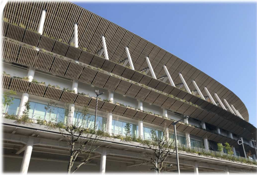
大成建設(株) 2019年度竣工 新国立競技場
