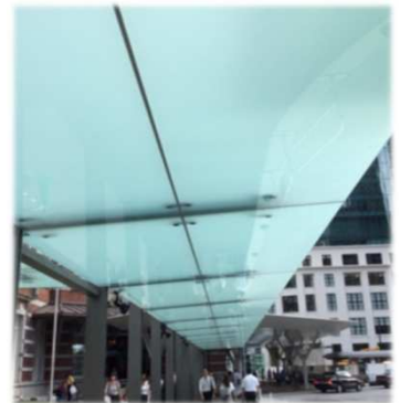
東京駅丸の内駅舎・歩道DPG庇・鹿島建設
