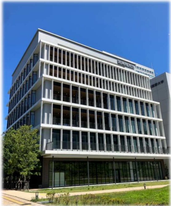
大成建設(株) 2021年度竣工 武蔵野大学
