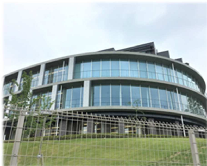
戸田建設(株) 2019年度竣工 日本文化大学2号館
