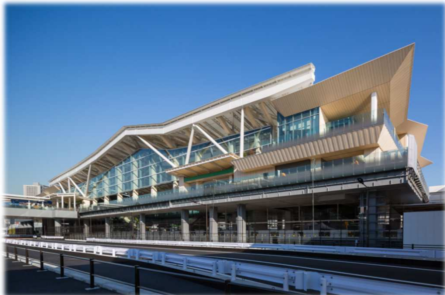
(株)大林組 2020年度竣工 高輪ゲートウェイ駅
