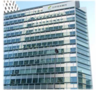
三井住友銀行呉服橋ビル・清水建設
